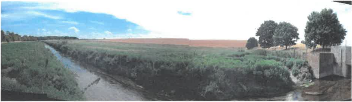
FIGURE 2 : PHOTOGRAPHIE DE LA CUVETTE, EN AMONT DE L'OUVRAGE DE RETENUE
