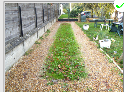
Revêtement stabilisé et bande centrale enherbée.
