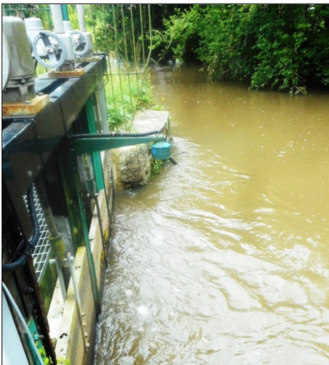
Crue juin 2018 relevés terrain
