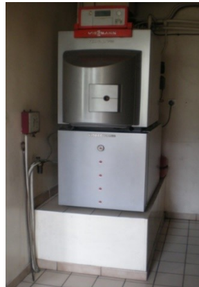
Réhausse de chaudière
