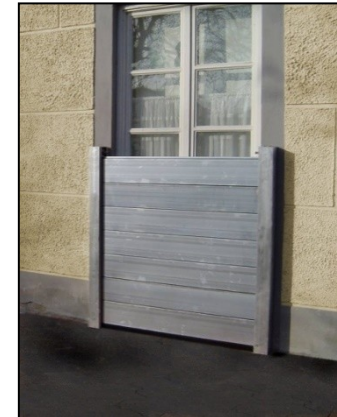
Pose de batardeaux
