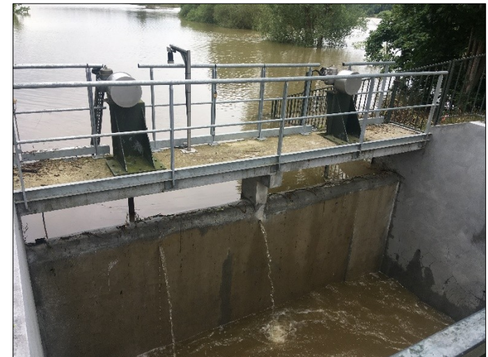
Crue juin 2018 relevés terrain
