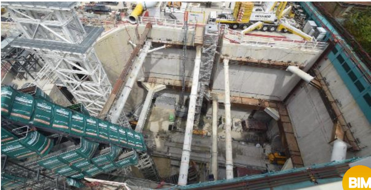
ARC Puits de lancement tunnelier
