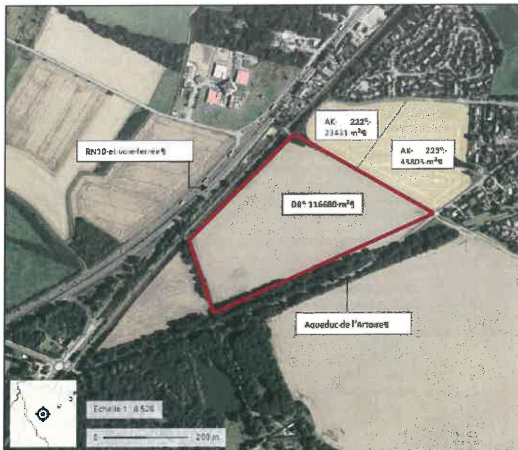
parcelles AK223 et AK222 (réserve foncière) : zones humides détruites parcelle D8 : zone de compensation (1,6ha de zones de remblais à soustraire à la surface totale de la parcelle)
